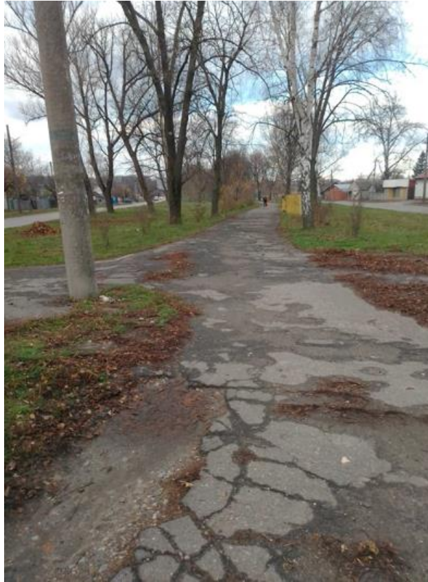
Рисунок 1 – Фрагмент ділянки дороги по вулиці Павлоградській м. Лозова
