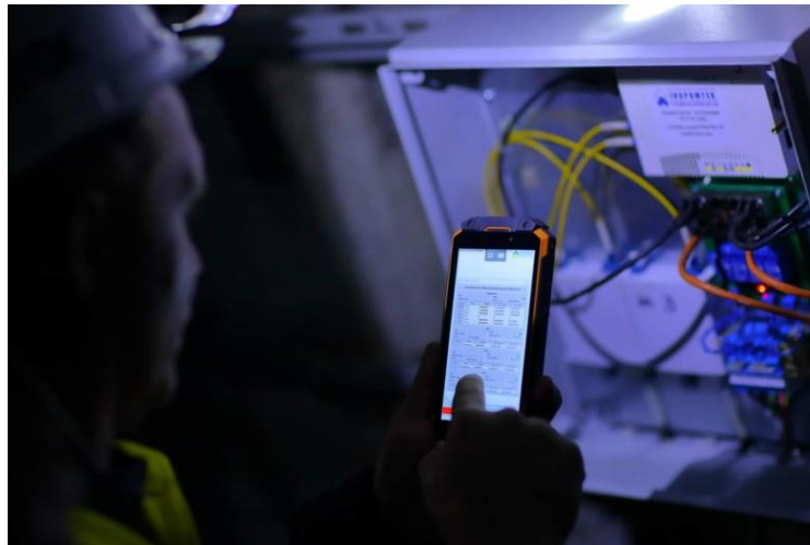
Рис. 2 Електрослюсар отримує завдання на смартфон в шахті. [5]
