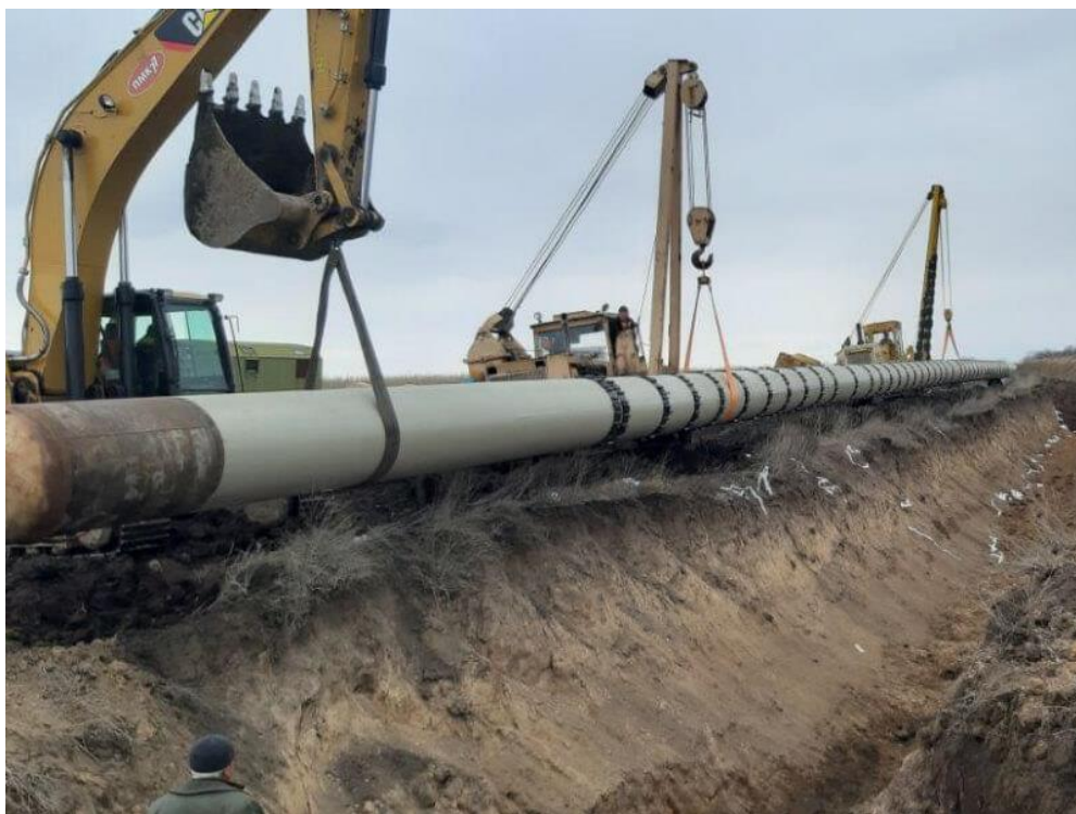
Рис. 1 Будівництво газопроводу – «ПМК-77»
