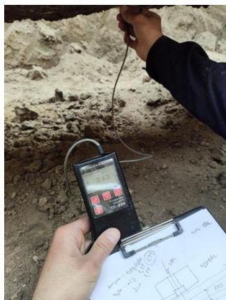
Рисунок 1. Інструментальні дослідження стану трубопровідної конструкції
